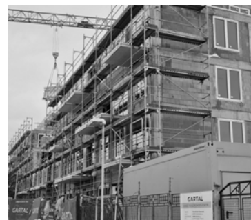
Dokončení hrubé stavby Zelené kaskády
